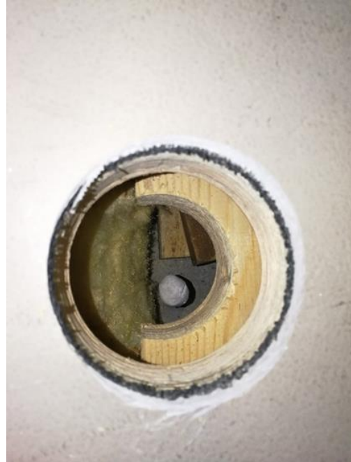
Kuva 4. Porareikämittaus liikuntasalin alapohjasta.
