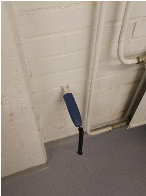
Kuva 1. Porareikämittaus kellarin seinästä.
