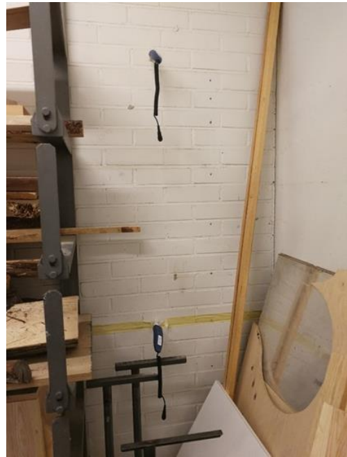
Kuva 2. Porareikämittaus kellarin seinästä.
