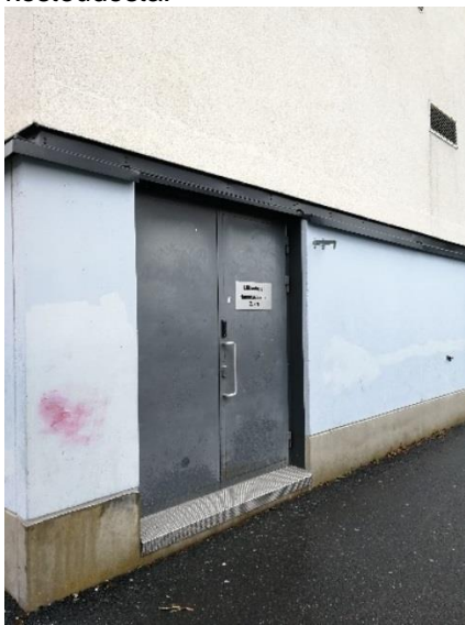
Kuva 9. Kynnys pellitetty.
